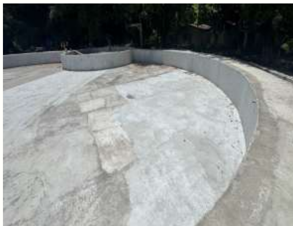
FOTO 7: REBOCO FINALIZADO TRECHO 02;
