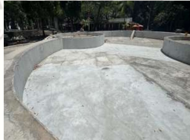
FOTO 6: REBOCO FINALIZADO TRECHO 02;
