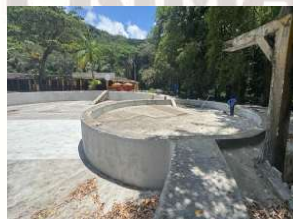
FOTO 5: REBOCO FINALIZADO TRECHO 02;
