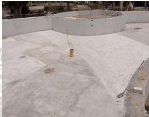
FOTO 8: REBOCO FINALIZADO TRECHO 02;
