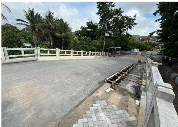
FOTO 7: APLICAÇÃO DE PAVER NO PASSEIO;
