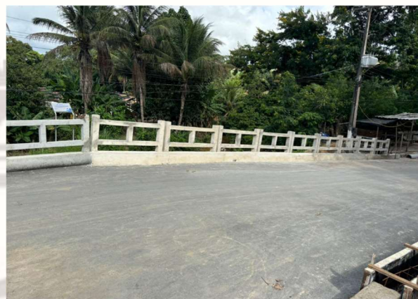
FOTO 8: APLICAÇÃO DE GUARDA CORPO;
