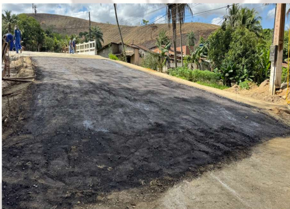
FOTO 3: IMPRIMAÇÃO NO 2º ENCONTRO;
