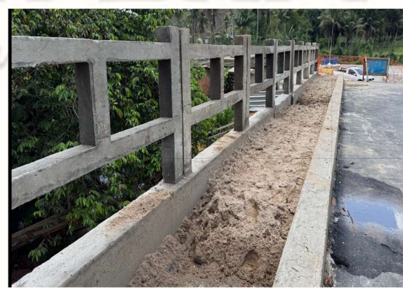
FOTO 6: ATERRO PARA APLICAÇÃO DE PAVER;
