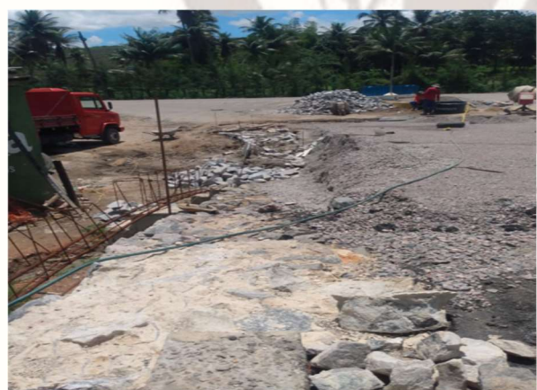
FOTO 09: COMPLEMENTO DE MURO;
