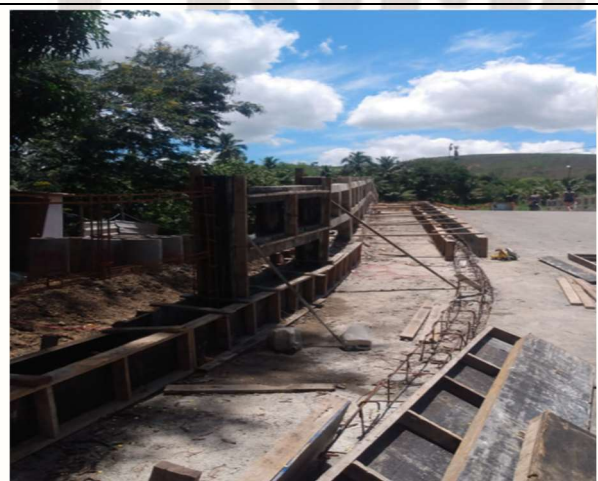
FOTO 11: PASSEIO 1º ENCONTRO SENDO EXECUTADO E FINALIZAÇÃO DA LAJE DE PASSEIO;
