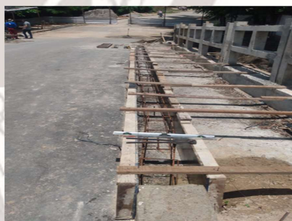
FOTO 10: VIGA DE MEIO FIO NA PONTE;
