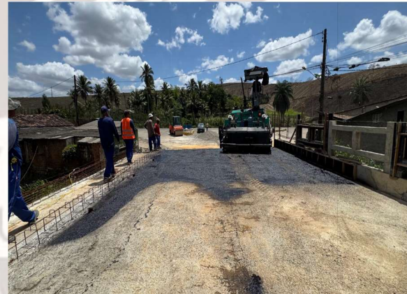
FOTO 4: IMPRIMAÇÃO E PINTURA NA PONTE;
