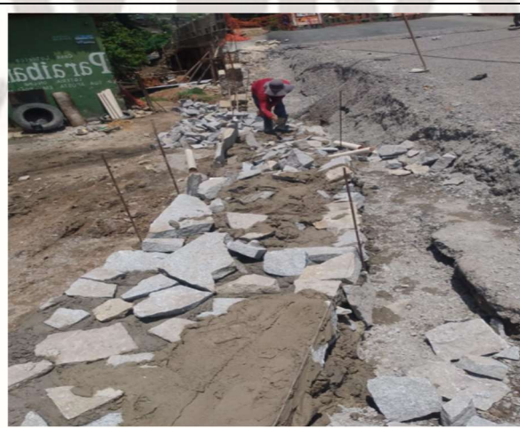
FOTO 12: COMPLEMENTO DO MURO.
