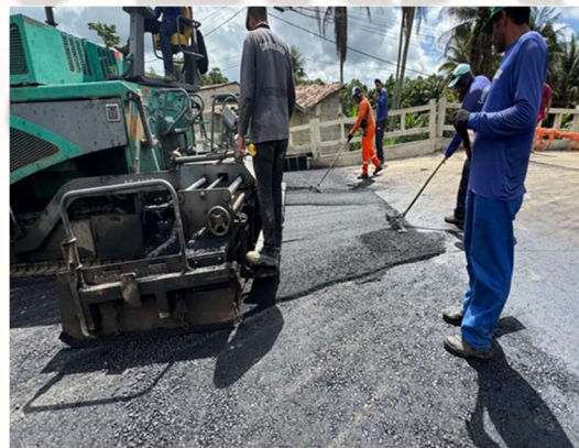
FOTO 6: EXECUÇÃO DA CAMADA DE CBUQ;
