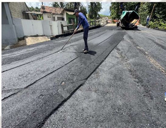
FOTO 3: EXECUÇÃO DA CAMADA DE CBUQ;
