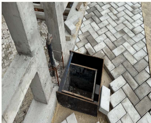
FOTO 7: CAIXA ELÉTRICA EM EXECUÇÃO;
