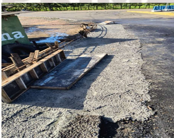
FOTO 11: CONCRETAGEM DO PASSEIO DO 1º ENCONTRO (JUSANTE);
