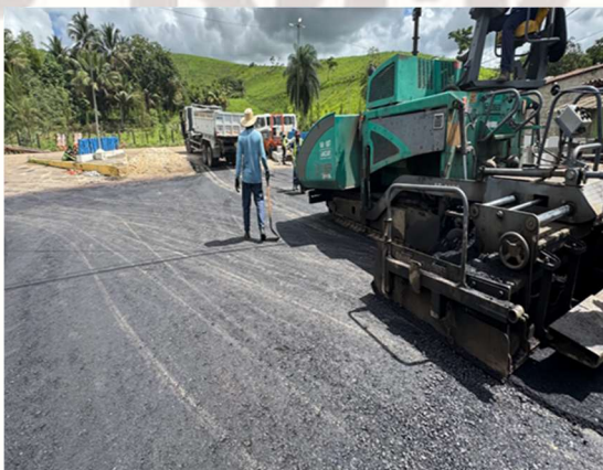
FOTO 5: EXECUÇÃO DA CAMADA DE CBUQ;
