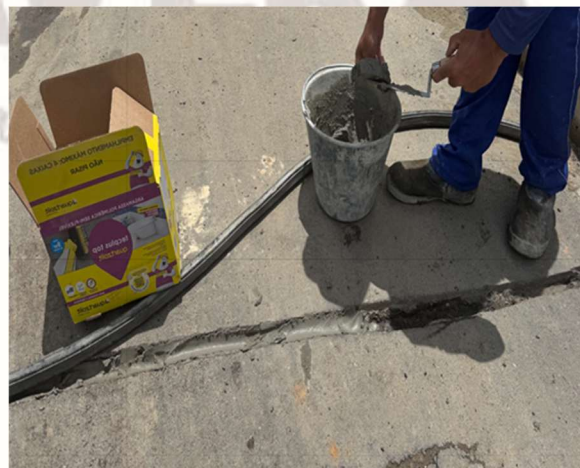
FOTO 12: INSTALAÇÃO DA JUNTA DE DILATAÇÃO;
