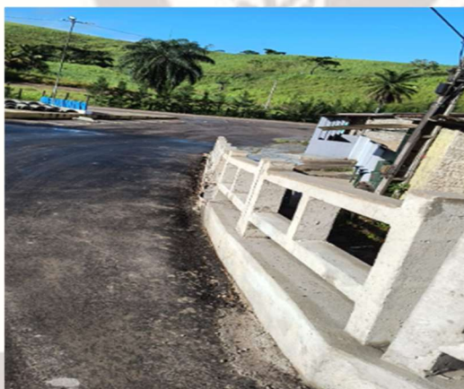
FOTO 09: GUARDA-CORPO EXECUTADO;
