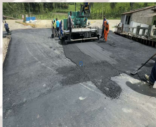
FOTO 4: EXECUÇÃO DA CAMADA DE CBUQ;
