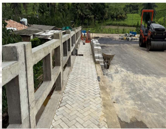
FOTO 8: INTERTRAVADO EXECUTADO;
