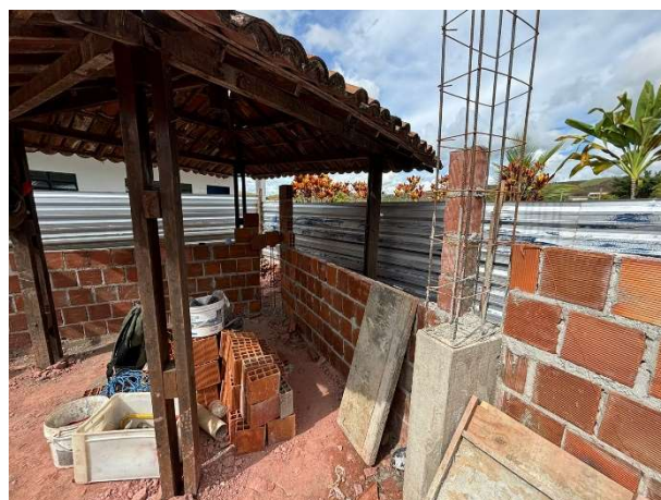
FOTO 4: ESTRUTURA EM EXECUÇÃO;
