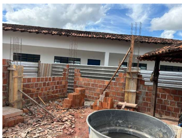
FOTO 5: ESTRUTURA EM EXECUÇÃO;
