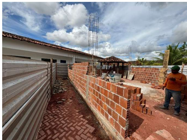
FOTO 7: ALVENARIA EXECUTADA;
