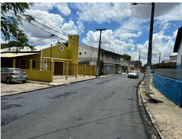
FOTO 5: CAMADA DE BINDER EXECUTADA;
