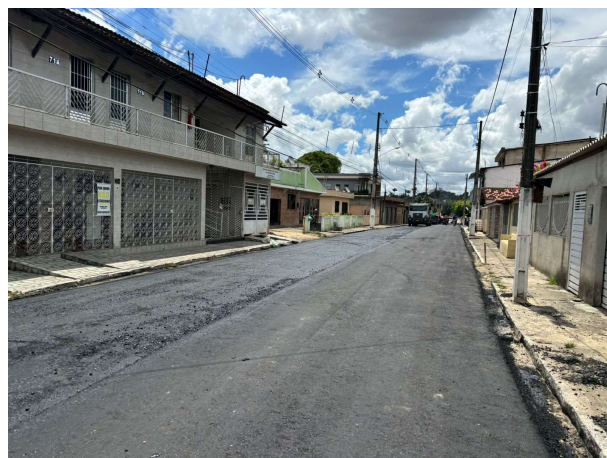
FOTO 6: CAMADA DE BINDER EXECUTADA;
