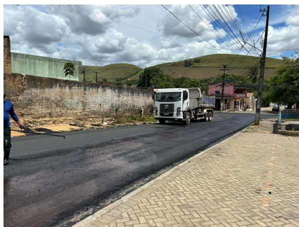
FOTO 1: CAMADA DE BINDER EXECUTADA;
