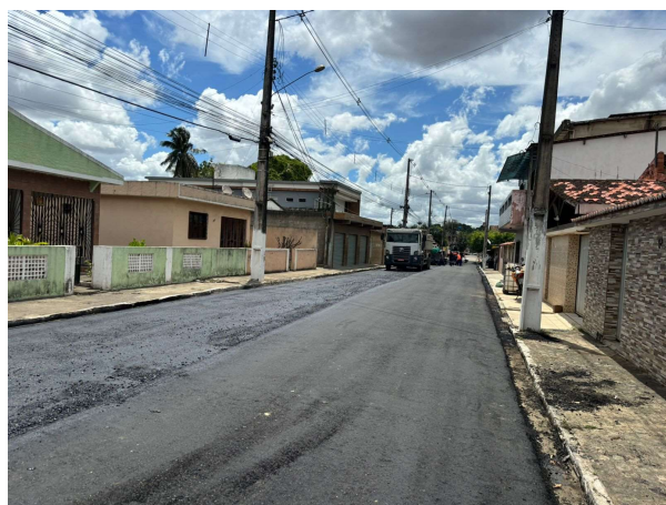
FOTO 7: CAMADA DE BINDER EXECUTADA;
