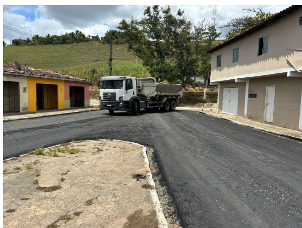
FOTO 11: CAMADA DE BINDER EXECUTADA;
