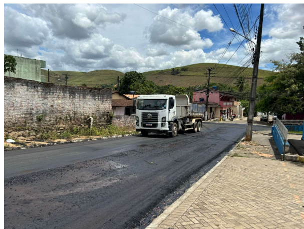
FOTO 4: CAMADA DE BINDER EXECUTADA;
