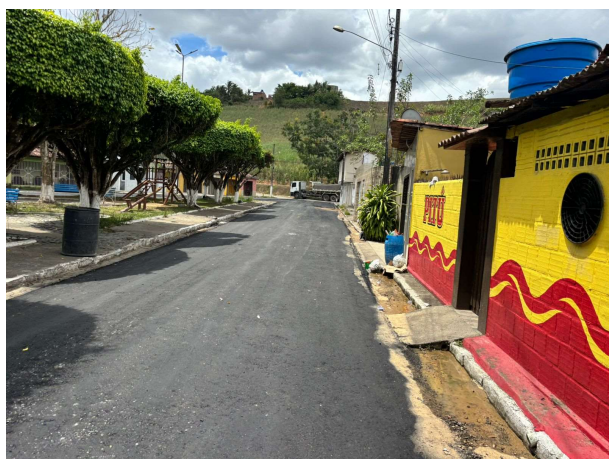
FOTO 09: CAMADA DE BINDER EXECUTADA;
