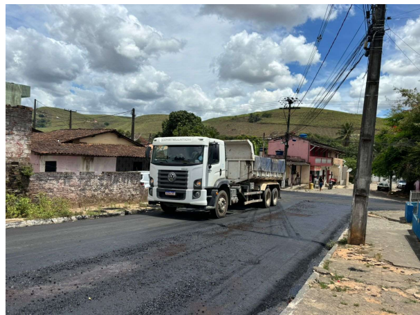
FOTO 2: CAMADA DE BINDER EXECUTADA;
