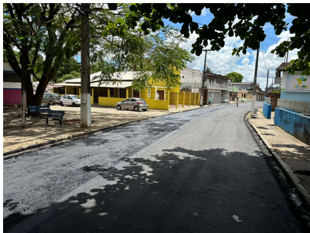
FOTO 8: CAMADA DE BINDER EXECUTADA;
