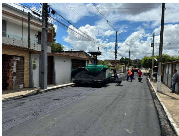
FOTO 10: CAMADA DE BINDER EXECUTADA;
