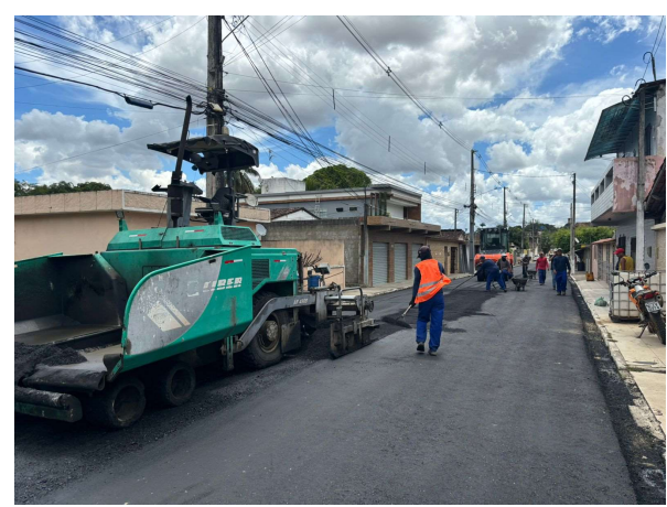
FOTO 12: CAMADA DE BINDER EXECUTADA;
