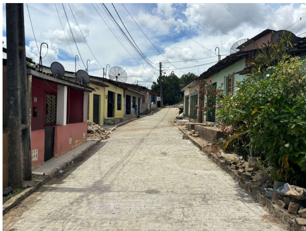
FOTO 7: PAVIMENTAÇÃO EM PARALELEPÍPEDOS GRANÍTICOS EXECUTADA;
