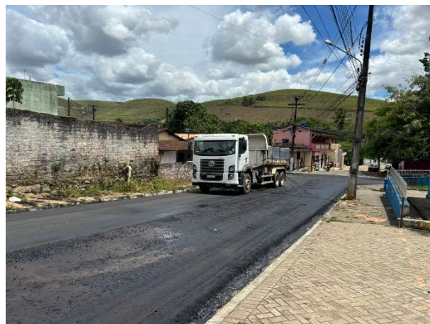
FOTO 4: CAMADA DE BINDER EXECUTADA;
