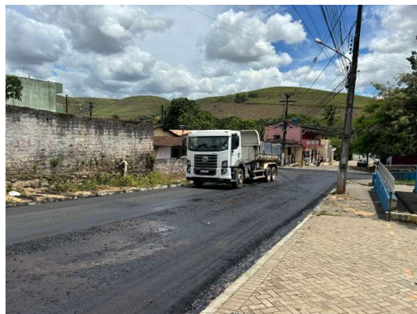
FOTO 4: CAMADA DE BINDER EXECUTADA;
