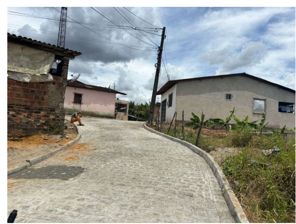
FOTO 12: PAVIMENTAÇÃO EM PARALELEPÍPEDOS GRANÍTICOS EXECUTADA;
