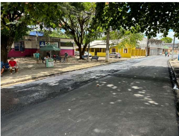
FOTO 3: CAMADA DE BINDER EXECUTADA;
