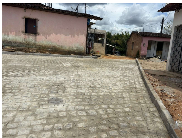
FOTO 09: PAVIMENTAÇÃO EM PARALELEPÍPEDOS GRANÍTICOS EXECUTADA;
