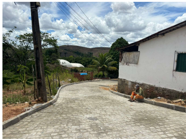
FOTO 8: PAVIMENTAÇÃO EM PARALELEPÍPEDOS GRANÍTICOS EXECUTADA;
