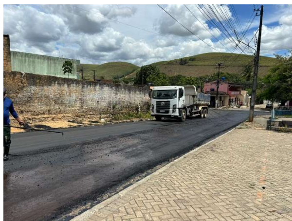
FOTO 1: CAMADA DE BINDER EXECUTADA;
