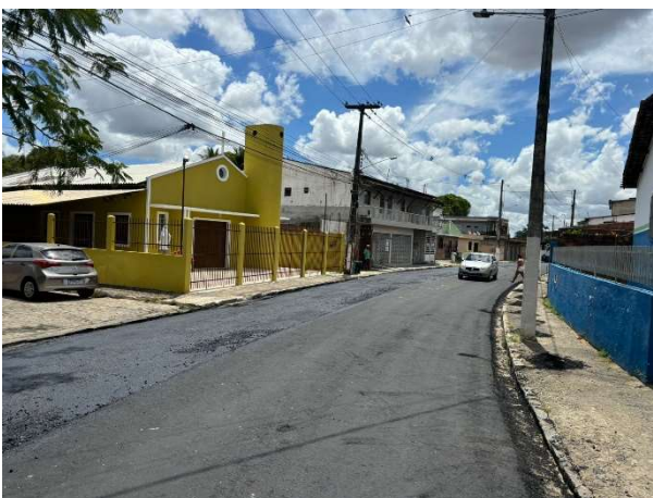
FOTO 5: CAMADA DE BINDER EXECUTADA;
