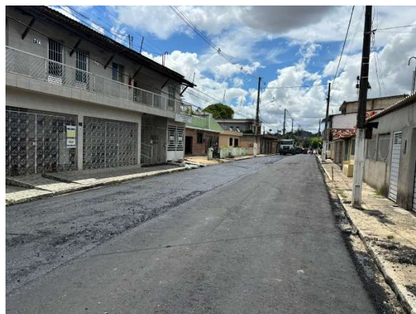
FOTO 6: CAMADA DE BINDER EXECUTADA;
