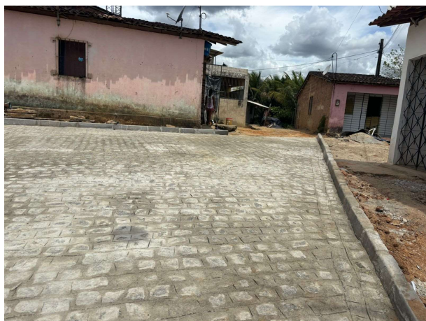
FOTO 09: PAVIMENTAÇÃO EM PARALELEPÍPEDOS GRANÍTICOS EXECUTADA;
