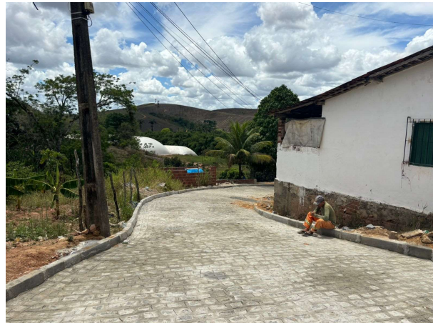
FOTO 8: PAVIMENTAÇÃO EM PARALELEPÍPEDOS GRANÍTICOS EXECUTADA;
