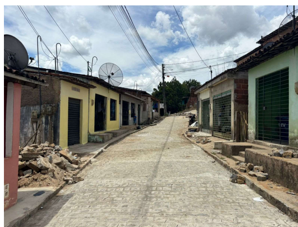
FOTO 10: PAVIMENTAÇÃO EM PARALELEPÍPEDOS GRANÍTICOS EXECUTADA;
