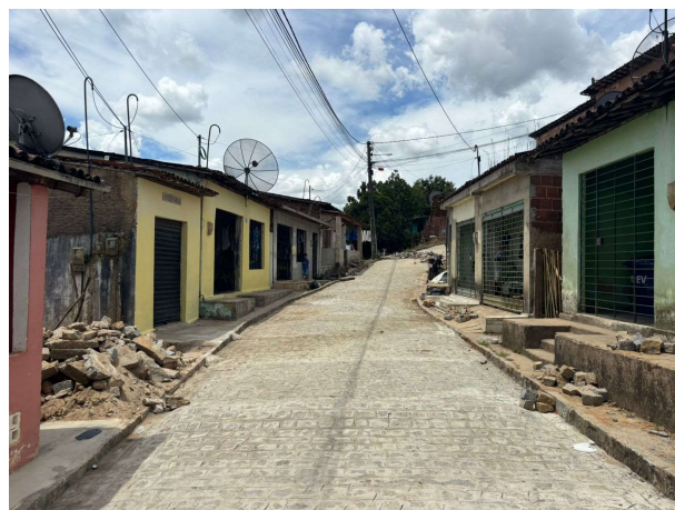
FOTO 10: PAVIMENTAÇÃO EM PARALELEPÍPEDOS GRANÍTICOS EXECUTADA;
