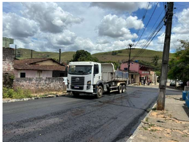
FOTO 2: CAMADA DE BINDER EXECUTADA;
