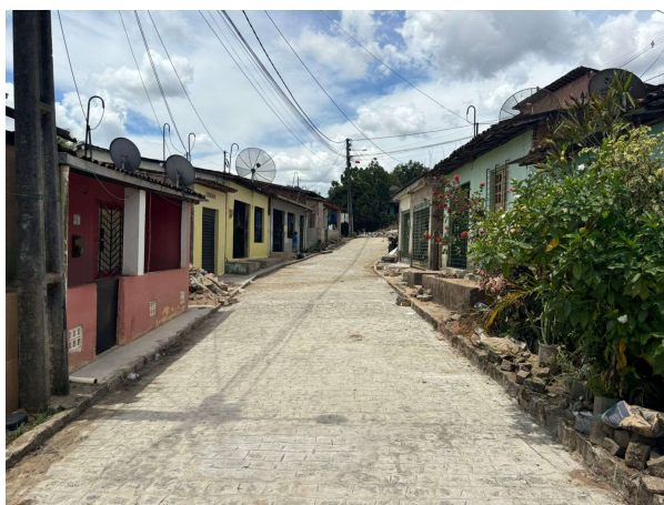
FOTO 7: PAVIMENTAÇÃO EM PARALELEPÍPEDOS GRANÍTICOS EXECUTADA;
