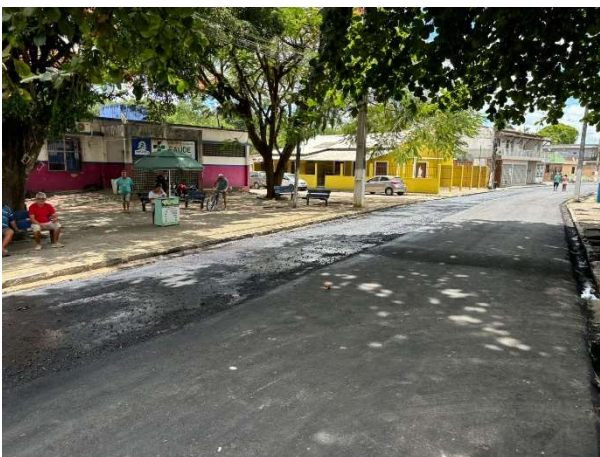
FOTO 3: CAMADA DE BINDER EXECUTADA;
