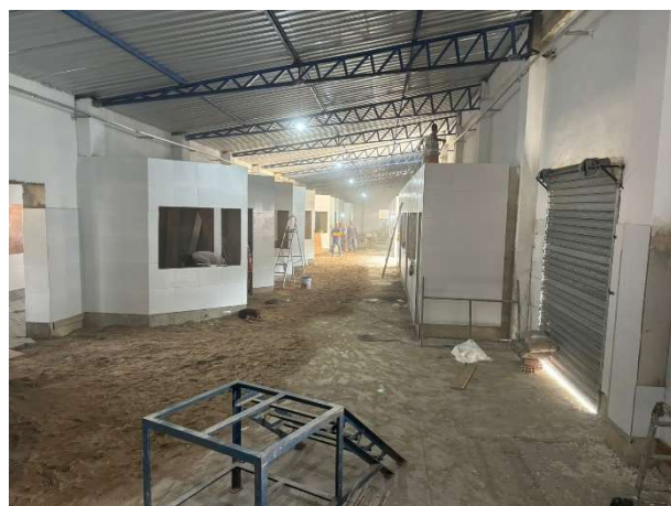
FOTO 3: REVESTIMENTO CERÂMICO EXECUTADO;
