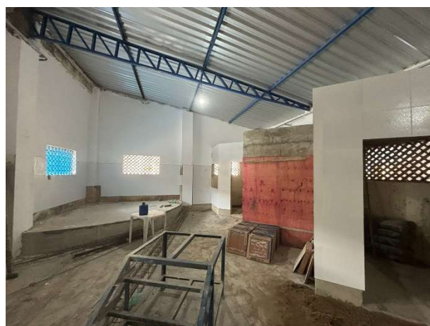
FOTO 5: REVESTIMENTO CERÂMICO EXECUTADO;
