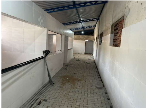
FOTO 8: PISO INTERTRAVADO EXECUTADO;
