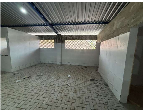
FOTO 09: PISO INTERTRAVADO EXECUTADO;
