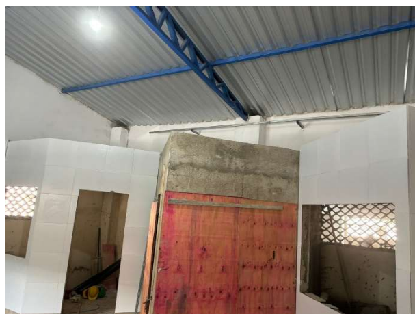
FOTO 4: REVESTIMENTO CERÂMICO EXECUTADO;
