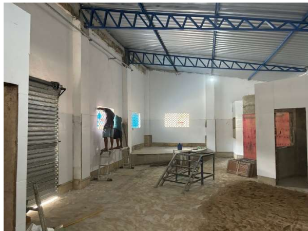
FOTO 7: REVESTIMENTO CERÂMICO EXECUTADO;
