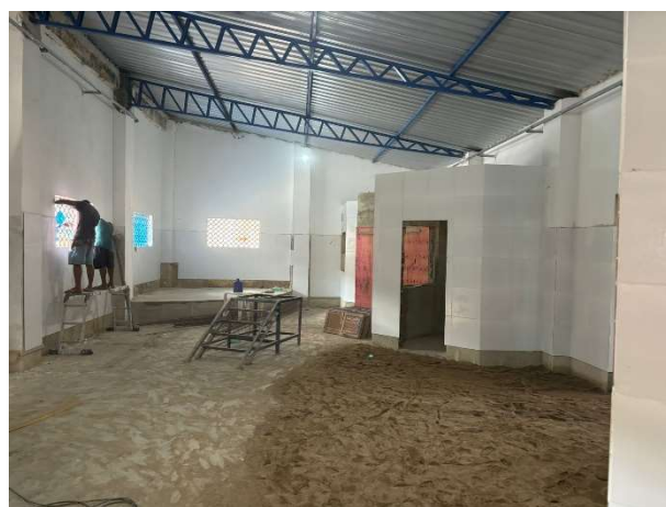
FOTO 6: REVESTIMENTO CERÂMICO EXECUTADO;
