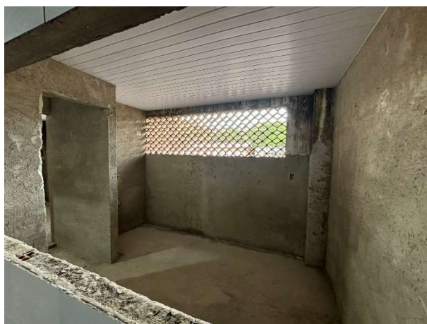
FOTO 10: FORRO DE PVC EXECUTADO;
