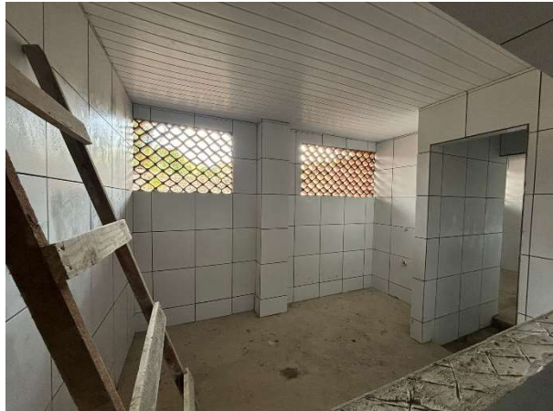
FOTO 8: REVESTIMENTO CERÂMICO EXECUTADO;
