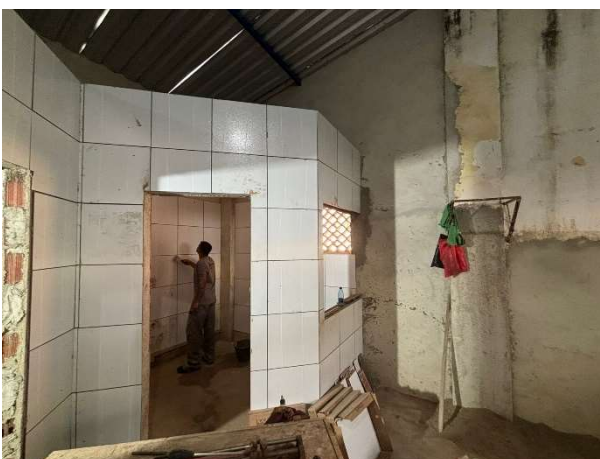
FOTO 3: REVESTIMENTO CERÂMICO EXECUTADO;
