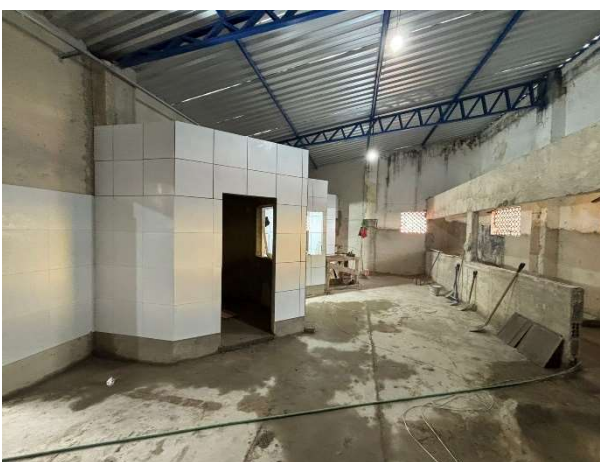
FOTO 5: REVESTIMENTO CERÂMICO EXECUTADO;
