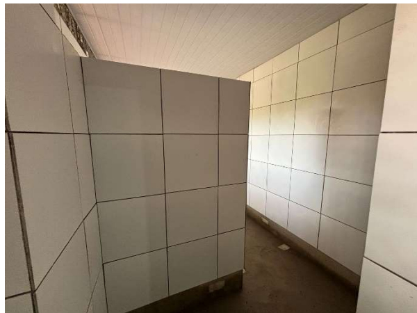
FOTO 7: REVESTIMENTO CERÂMICO EXECUTADO;
