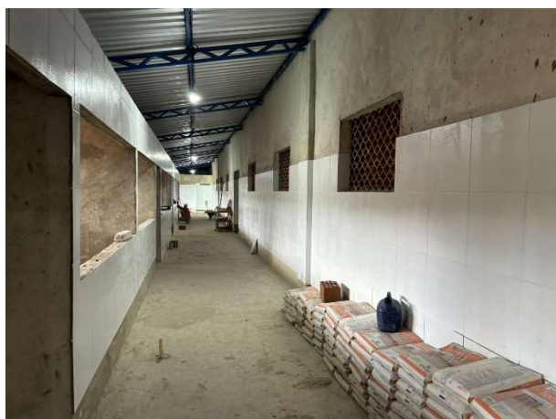
FOTO 09: REVESTIMENTO CERÂMICO EXECUTADO;
