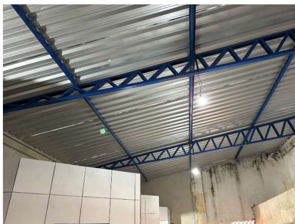
FOTO 4: ELETRODUTO RÍGIDO INSTALADO;
