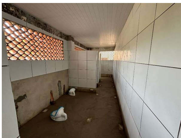
FOTO 6: REVESTIMENTO CERÂMICO EXECUTADO;
