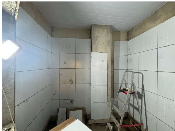
FOTO 1: REVESTIMENTO CERÂMICO EXECUTADO;
