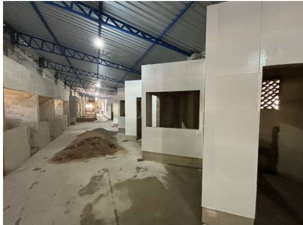
FOTO 2: REVESTIMENTO CERÂMICO EXECUTADO;
