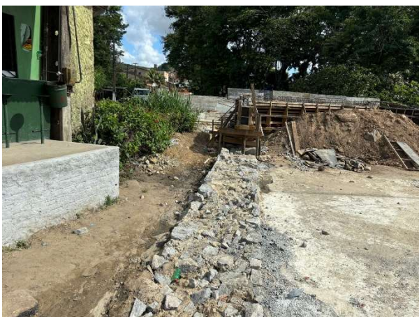
FOTO 3: MURO DE ARRIMO EM EXECUÇÃO;
