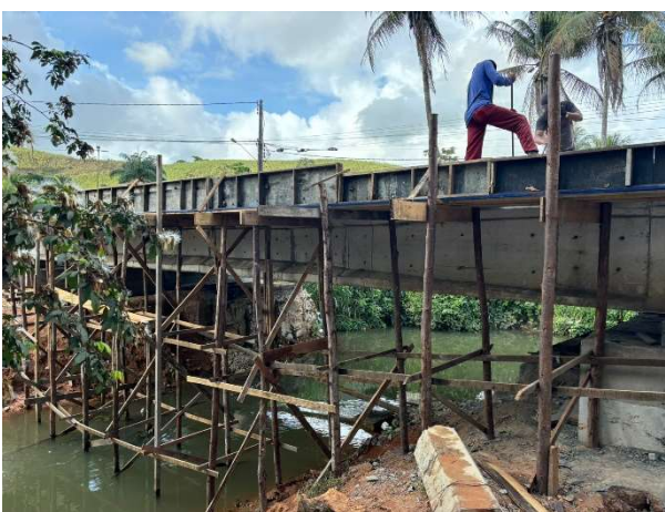
FOTO 5: FORMA DO TABULEITO EXECUTADA;
