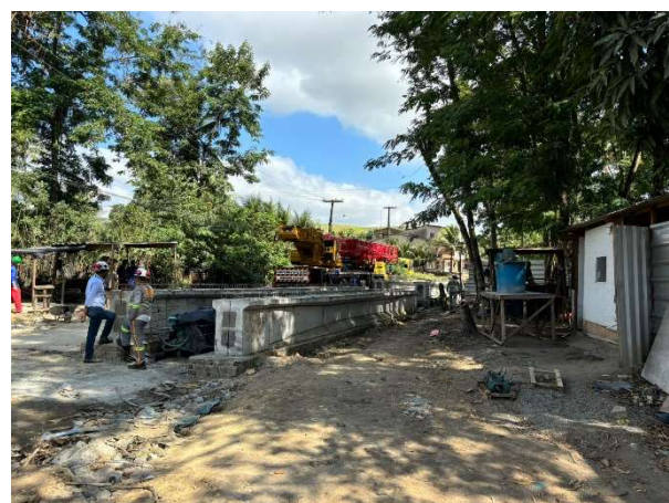
FOTO 4: MURO DE ARRIMO EM EXECUÇÃO;
